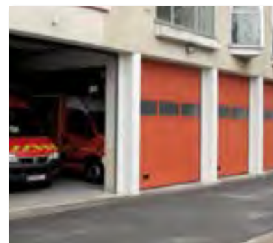
Mixage panneaux isolés et 1 panneau vitré sur porte sectionnelle Industrie
