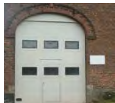
Exemple de faux-linteau d'habillage
