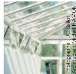
Châssis fixé entre 2 chevrons
