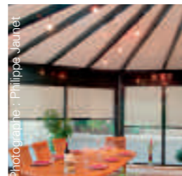
Panneaux isolants en toiture et volets roulants intégrés en façade
